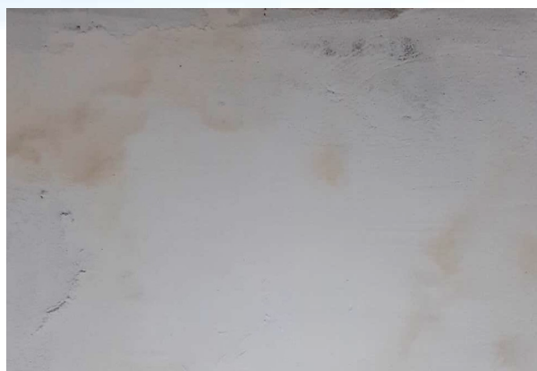
Infiltrações reaparecendo
