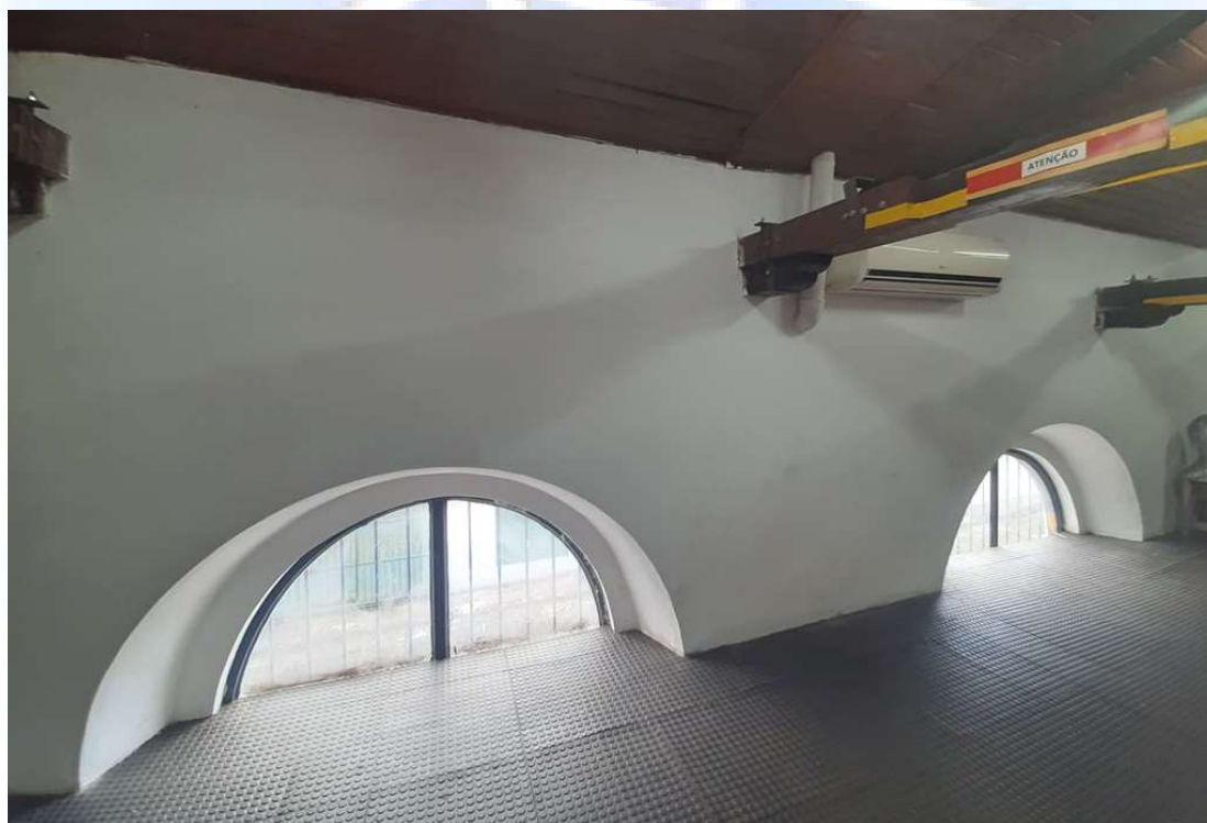
Após o término da obra
