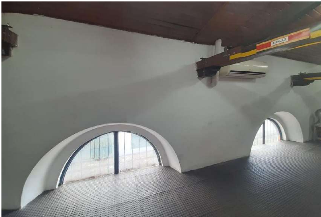
Após o término da obra
